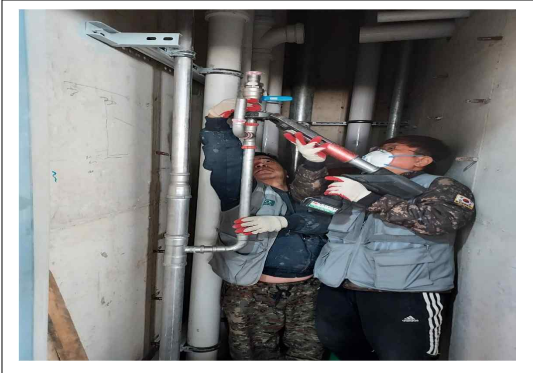
각 층 P.D 배관 작업
