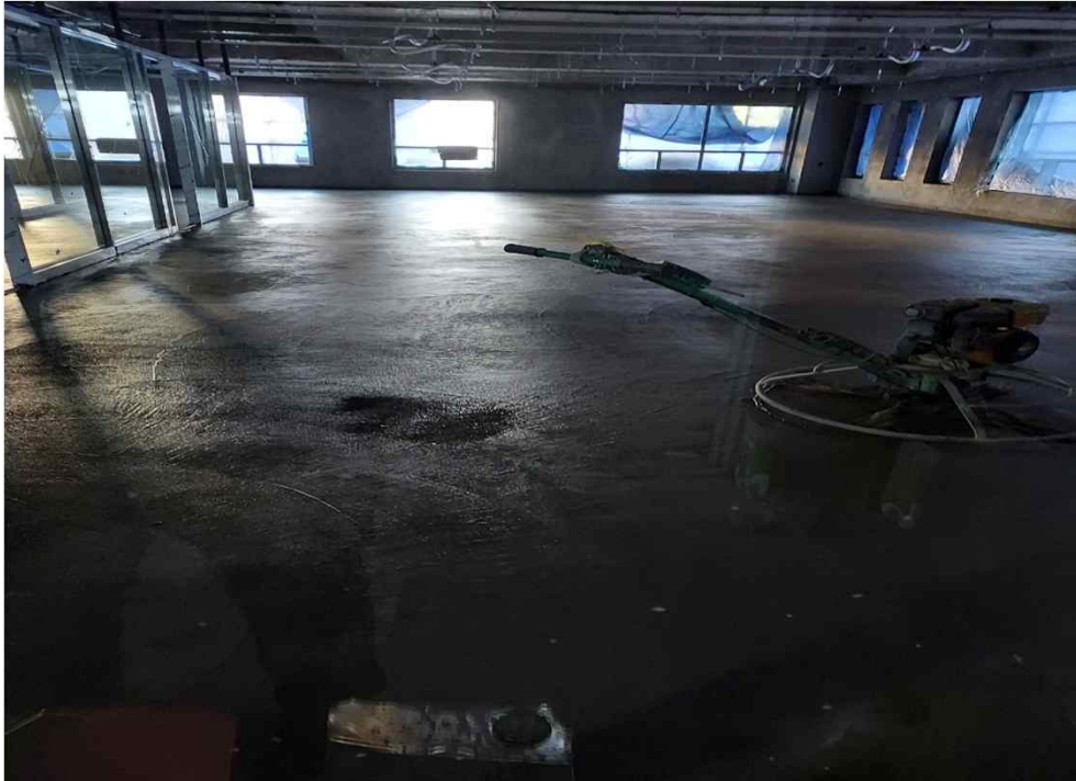
각 층 바닥 미장작업
