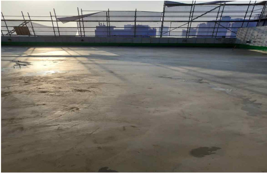
옥상 누름 콘크리트 타설 및 양생(11.05)
