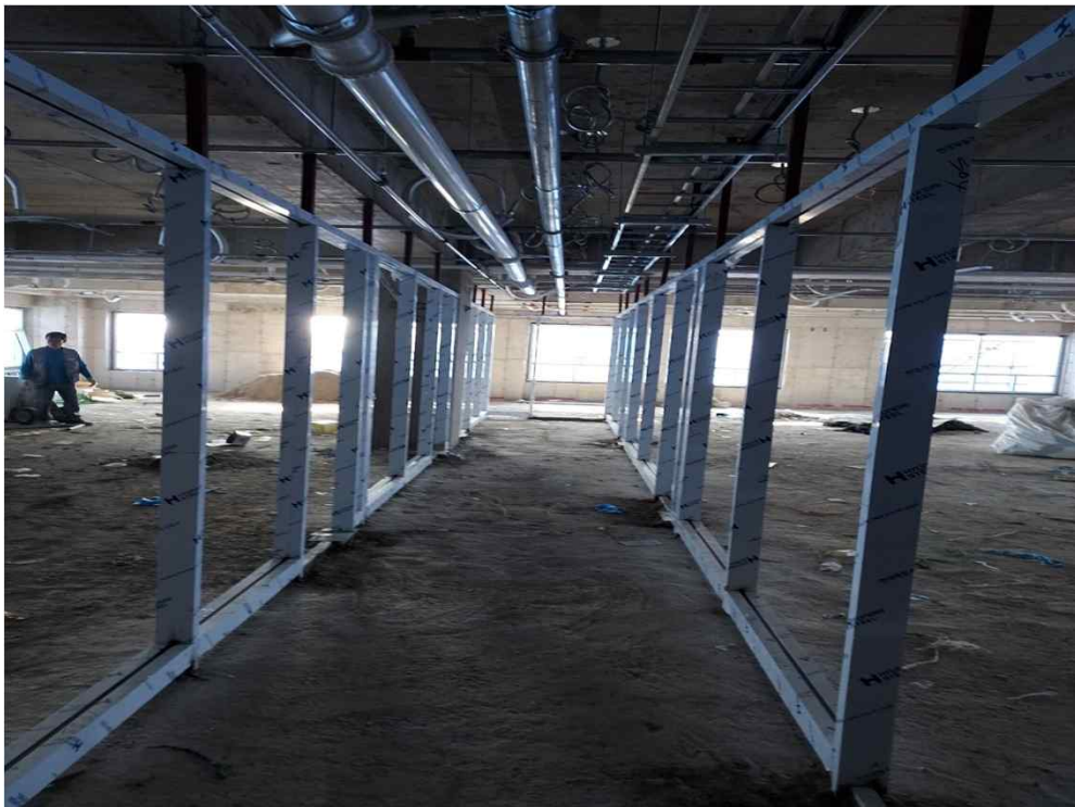
통로부분 칸막이 설치
